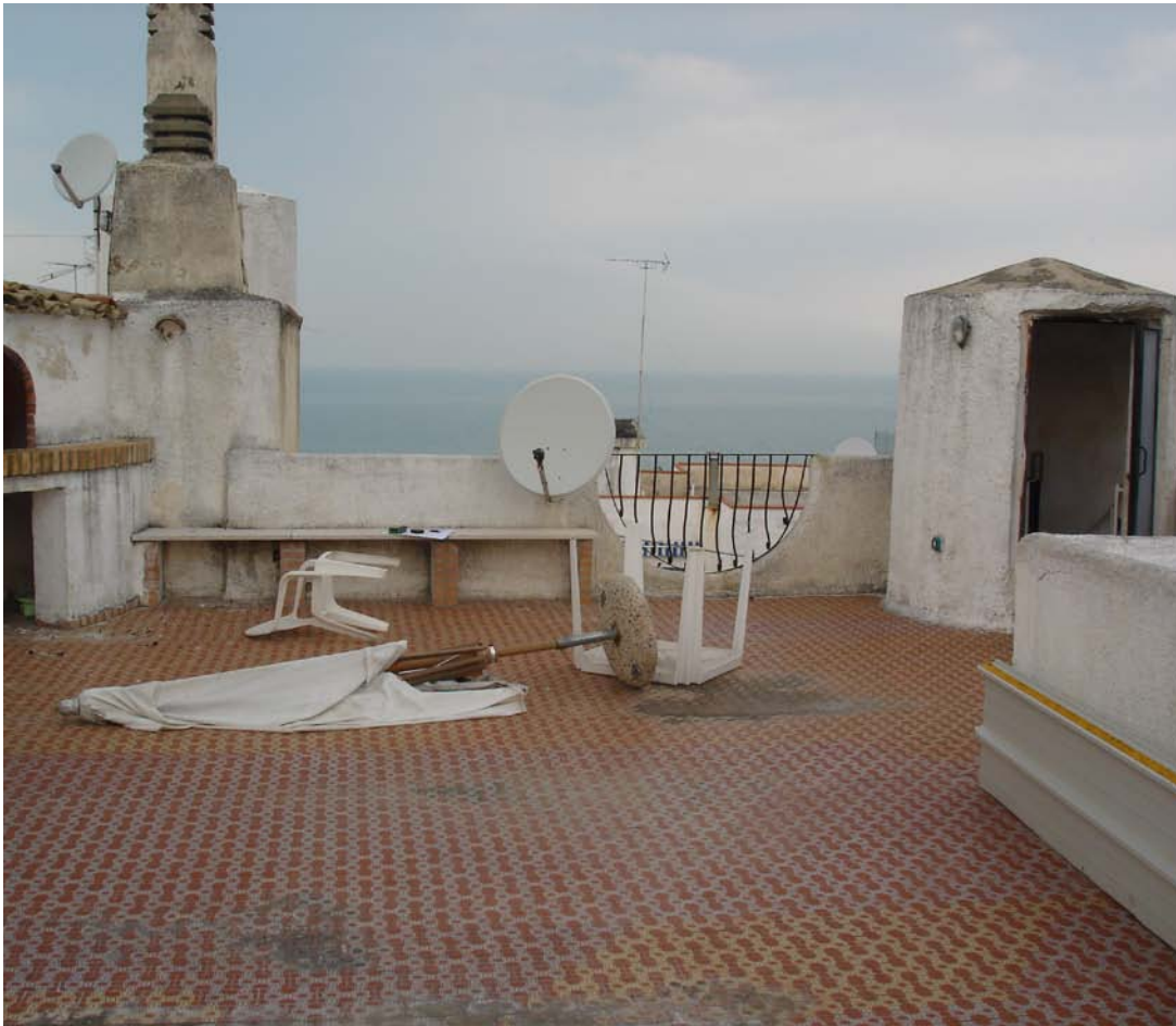
foto 13 zona forno e corpo scala terrazzo
